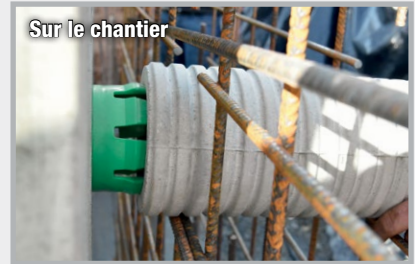
Montage d'un manchon double de tout-à-l'égout
