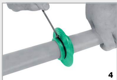
4 Bien serrer les deux bandes de serrage à la main
