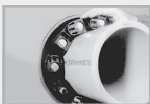
Placer MASTER-SEAL dans l'espace annulaire.
