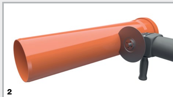
2 Découpe du tube KG ou KG 2000 : largeur de voile moins 8,5 cm
