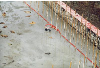
Der Schlauch wird mittig, innerhalb der Bewehrung in der Arbeitsfuge verlegt.
