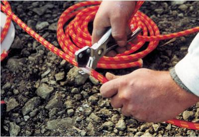
Die Anlieferung erfolgt auf einer Rolle mit 100 m Länge. Schlauch zum Ablängen mit Filamentband umkleben und mit einem geeigneten Werkzeug mittig scharfkantig durchtrennen.
