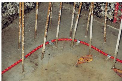
Generelle Richtungsänderungen sind mit einem ausreichenden Biegeradius auszuführen um eine Beschädigung des Schlauches bzw. eine Behinderung der ganzheitlichen Verpressung zu vermeiden.
