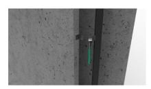
Die verstellbaren Befestigungslaschen werden zur stirnseitigen Fixierung an der Wandschale angepasst.
