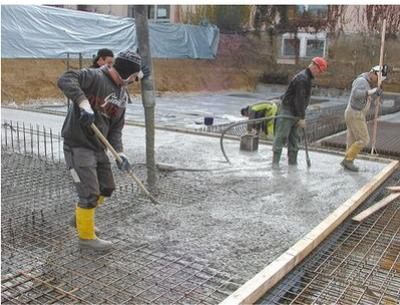
Vor der Betonage des ersten Abschnitts muss die Schutzfolie vom Dichtblech entfernt werden.
