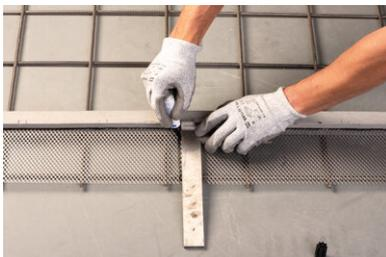
Mit einem Lineal oder Winkel an den Markierungen die Position der Bewehrung, auf dem Streckmetall anzeichnen.
