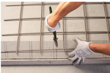
Mit einer Blechschere oder einem anderen geeigneten Werkzeug entlang der Markierungen das Streckmetall einschneiden.
