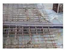
Das **Abschalelement ABS** wird zwischen der unteren und oberen,Bereich Sohle – Sohle, bzw. äußeren und inneren, Bereich Wand-Wand, Bewehrungslage eingestellt. Eine Anpassung der Bewehrung ist nicht notwendig. Das Lochblech wird mittels Bindedraht an der Bewehrung befestigt.
