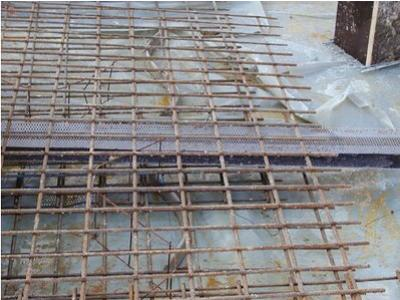
Das **Abschalelement ABS** wird zwischen der unteren und oberen, Bereich Sohle – Sohle, bzw. äußeren und inneren, Bereich Wand-Wand, Bewehrungslage eingestellt.
