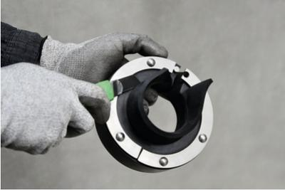
Den Dichtungseinsatz der **MASTER-Ring Multi-geteilt** auf den Durchmesser der Medienleitung anpassen. Hierfür die benötigten Ringe nach hinten durch die Dichtung schieben und mit dem Cuttermesser abschneiden
