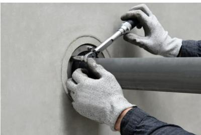
Mit einem Drehmomentschlüssel die Muttern auf das vorgeschriebene Drehmoment ( $\varnothing 100/150/200 = 5\text{Nm}$ ;  $\varnothing 250 = 10\text{Nm}$ ) festziehen.
