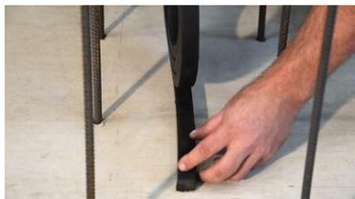
Après l'application de la colle pour joint gonflant, appliquer le **joint gonflant à la bentonite MASTERSTOP** sur la colle et y appuyer uniformément.
