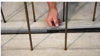
En cas de joints bout à bout dans la ligne droite et en cas d'utilisation de grilles pour joint gonflant les joints de joint gonflant et de grille de joint gonflant devraient être exécutés avec décalage.
