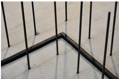
Des joints aux angles ou le long de lignes droites doivent toujours être exécutés comme joints bout à bout.
