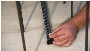
Poser la grille pour joint gonflant fermement sur le joint gonflant à la bentonite MASTERSTOP et la fixer sur le béton à l'aide de clous.
