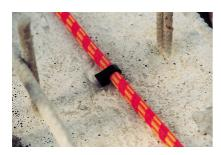
La fixation à l'aide de clips en plastique est également possible. Les clips en plastique sont mis en place dans le béton frais ou enfoncés après coup dans un trou d'un diamètre de 8 mm.
