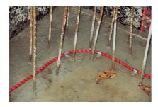
Les changements de direction généraux doivent être effectués avec un rayon de courbure suffisant pour éviter d'endommager le tuyau ou d'empêcher l'injection complète. Le rayon limite est de 5 cm.
