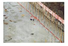
Le tuyau est mis en place au centre du joint de construction, à l'intérieur de l'armature.
