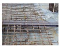
L'élément de coffrage de tôle d'étanchéité ABS est mis en place dans les couches de l'armature entre les zones base/base inférieure et supérieure, ou entre les zones mur/mur extérieure et intérieure.
