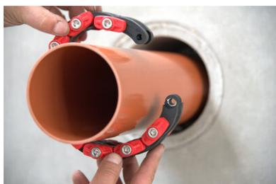
En utilisant un joint modulaire **MASTER-SEAL** en combinaison avec une installation existante, placer le joint modulaire „ouvert“ autour du tube médiatique existant et le fermer comme décrit au début.
