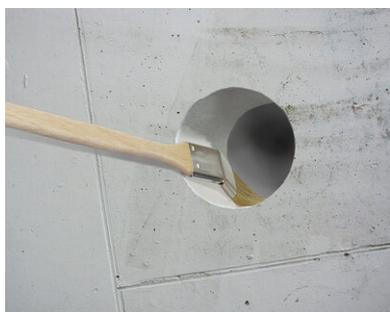
En cas de pose d'un joint modulaire **MASTER-SEAL** dans un carottage il faut auparavant appliquer un traitement conservateur sur la surface intérieure du carottage avec de la résine époxy (PROTECT résine EP).
