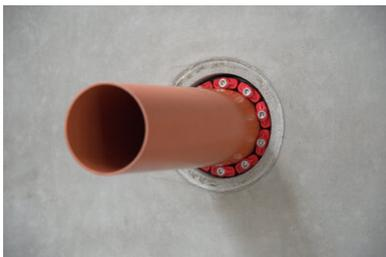
Montage achevé du tube médiatique, y compris étanchement avec le joint modulaire **MASTER-SEAL**.
