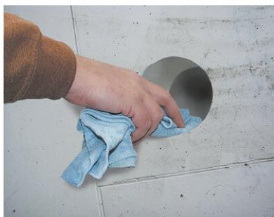
Avant de procéder au montage du joint modulaire **MASTER-SEAL** nettoyer la surface intérieure du passage de mur ainsi que la surface extérieure du tube médiatique (tube à gaz, tube à eau, tube à eau résiduelle ou bien câbles).
