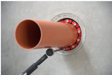
Serrer les vis successivement et en sens horaire à l'aide d'une clé dynamométrique.
