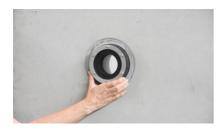
Placer l'insert d'étanchéité **MASTER-RING** dans le tube fourreau ou bien dans le carottage qui a subi un traitement conservateur et y faire passer le tube médiatique.
