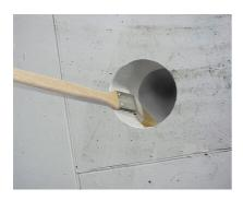
En cas de pose d'un insert d'étanchéité **MASTER-RING** dans un carottage il faut auparavant appliquer un traitement conservateur sur la surface intérieure du carottage avec de la résine époxy (PROTECT résine EP).
