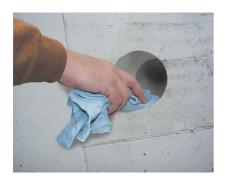
Avant de procéder au montage de l'insert d'étanchéité **MASTER-RING** nettoyer la surface intérieure du passage de mur ainsi que la surface extérieure du tube médiatique (tube à gaz, tube à eau, tube à eau résiduelle ou bien câbles). Dans la zone d'étanchéité les conduites médiatiques doivent être indéformables et ne présenter aucun endommagement.
