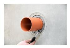
Serrer les écrous successivement et en quinconce à l'aide d'une clé dynamométrique.
